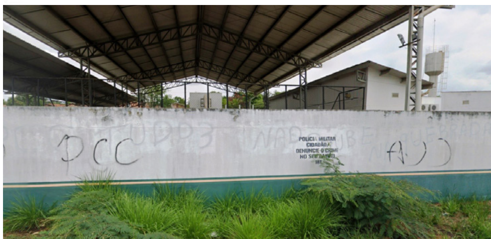
Figura 3.1 | Muro de Escola Pública com pichação do PCC e CCA Altamira – PA, 2025
