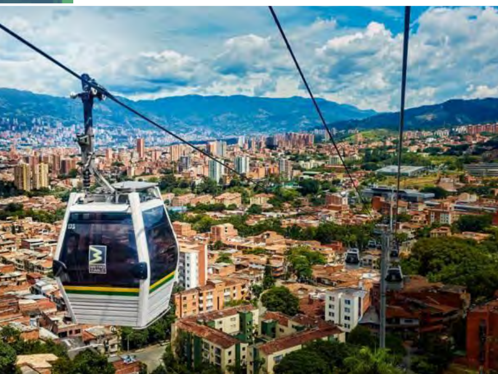
Figura 1: Teleférico construído na Comuna 1, em Medellín.
